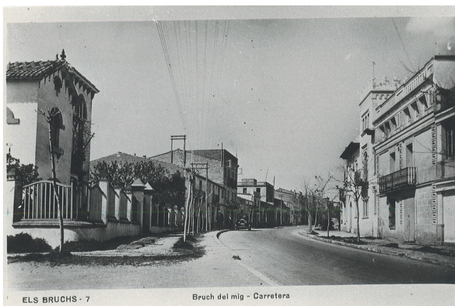
Carrer del Bruc del Mig. A dreta i esquerra, edificis modernistes. Inicis del segle xx.
